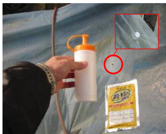
（ダクト投入孔からの投入）
